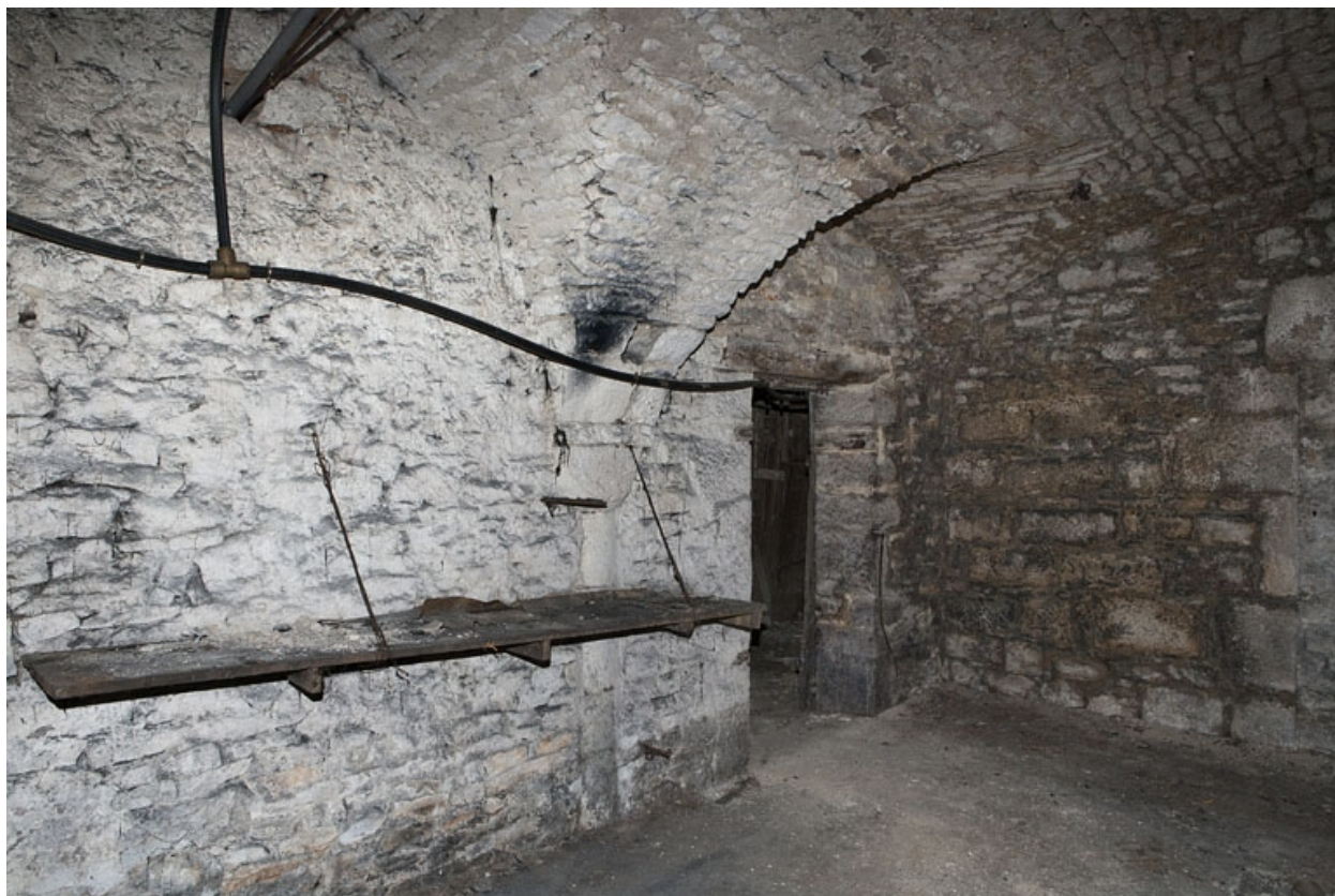
Logis principal, sous-sol : cave C.
