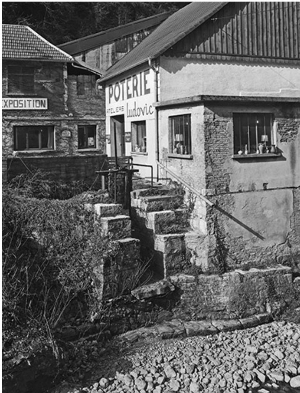
Vannage et déversoir du canal d'amenée.
