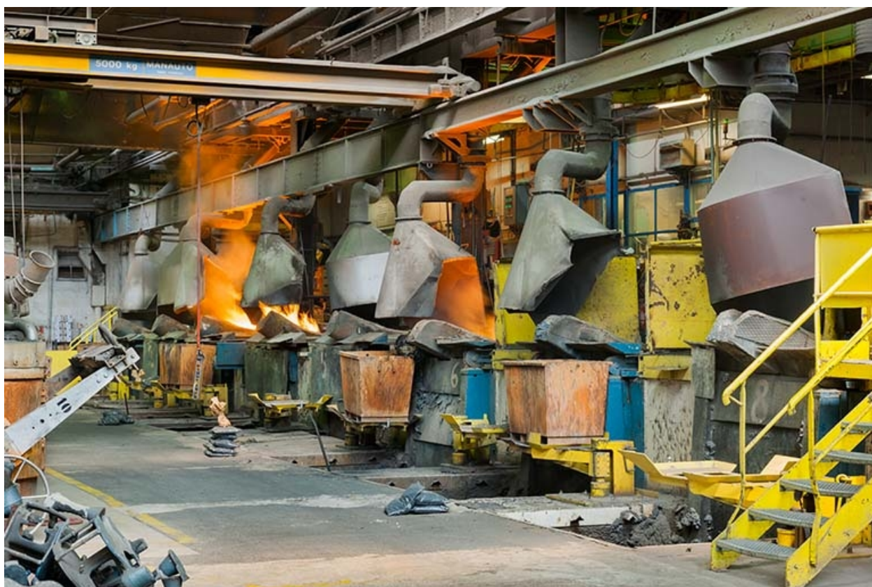
Batterie de fours à induction (3).
