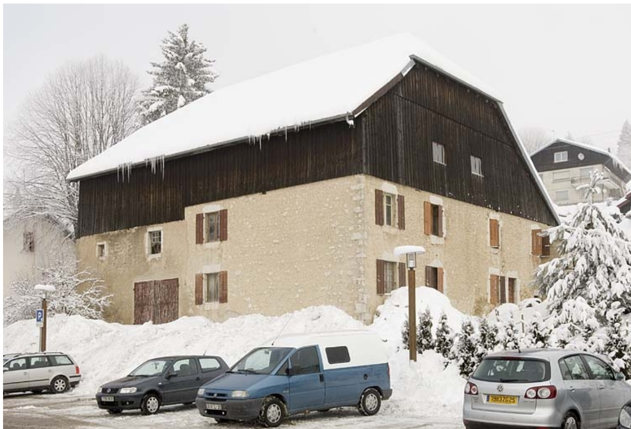
Façades postérieure et latérale gauche, en hiver.
