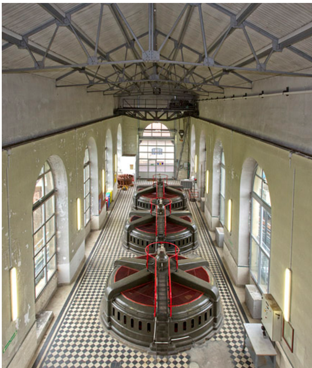
Salle des machines. Alignement des groupes turbo-alternateurs.
