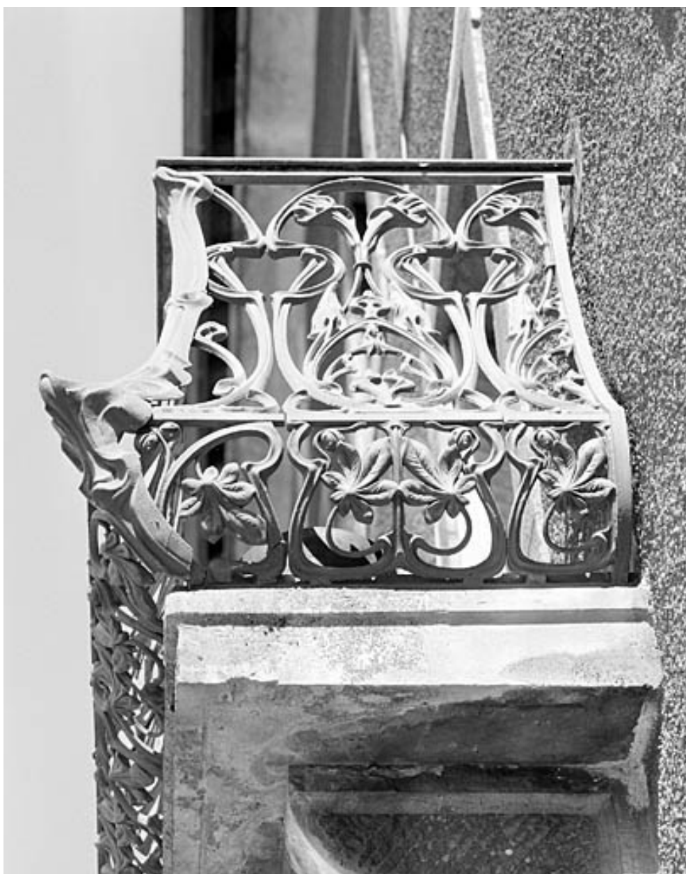
Balcon de l'immeuble : détail du garde-corps.
