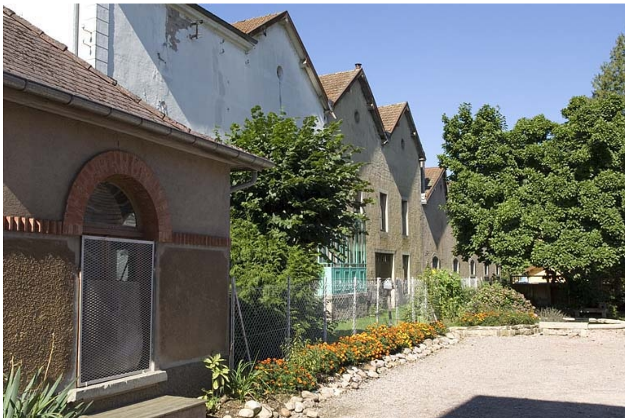
Façade postérieure de l'atelier de fabrication nord.
