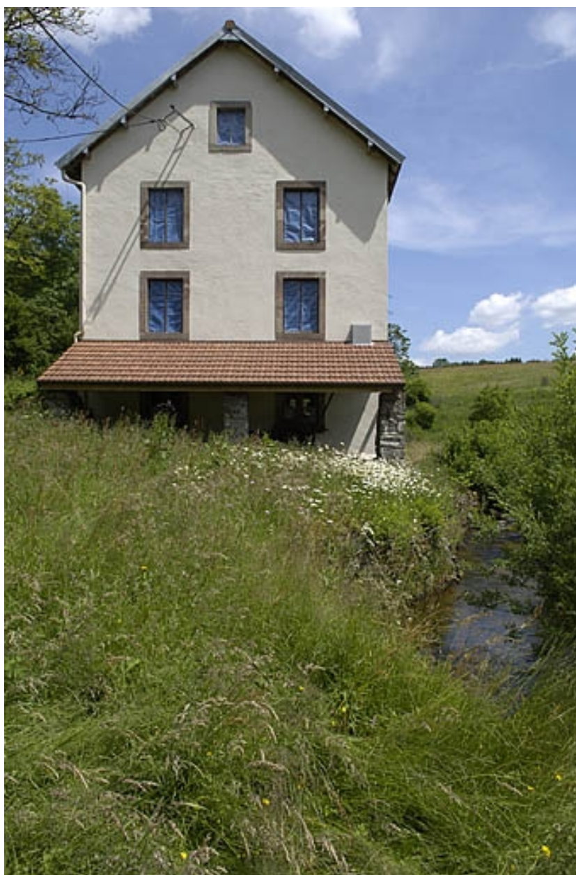
Façade nord-ouest et appentis abritant la turbine.
