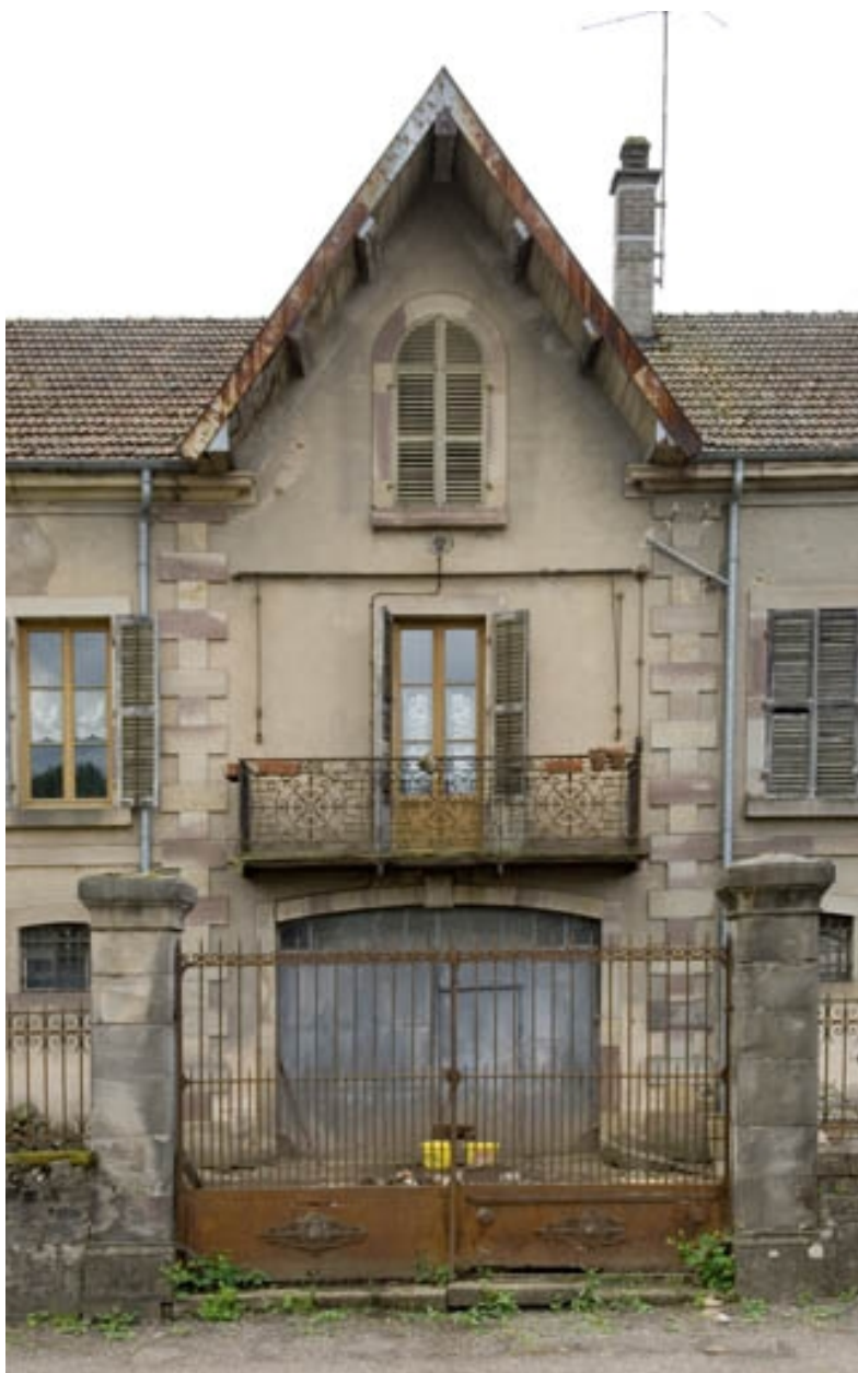
Façade antérieure. Pignon central.
