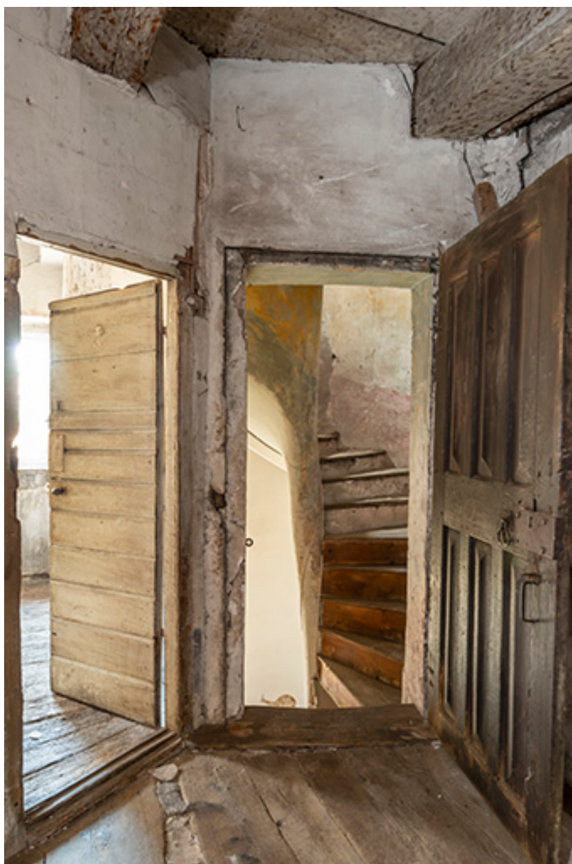
Entrée du couloir depuis la tour polygonale.
