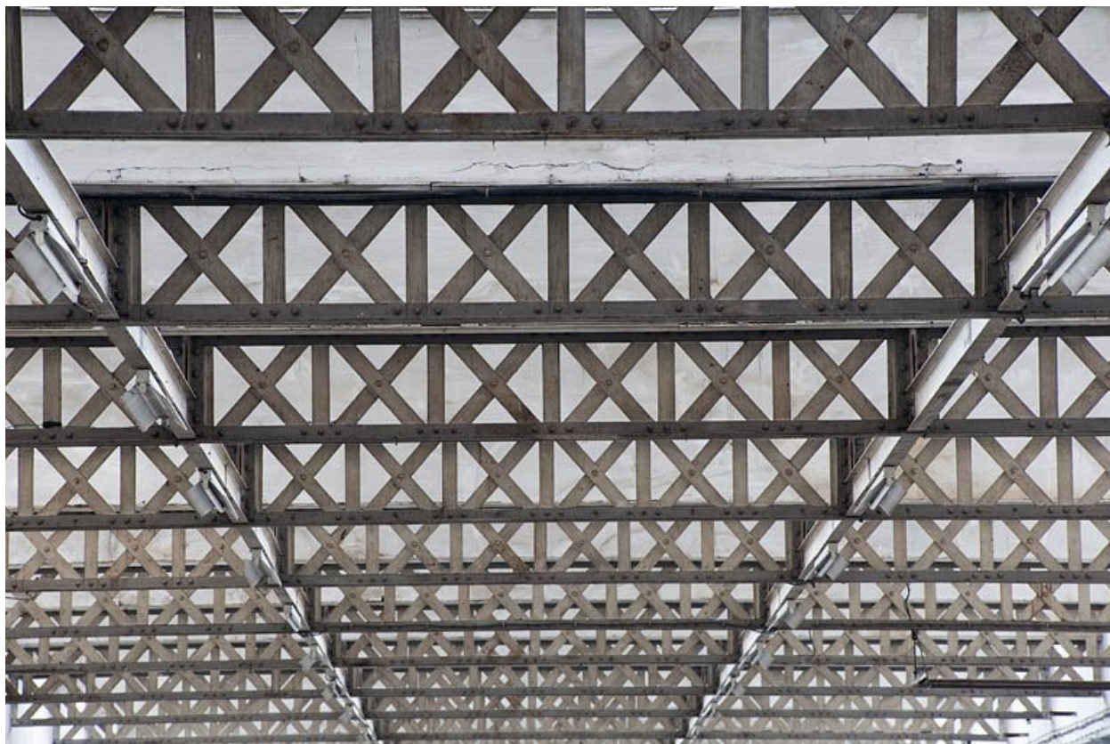
Extension ouest. Poutrelles à treillis de la charpente.
