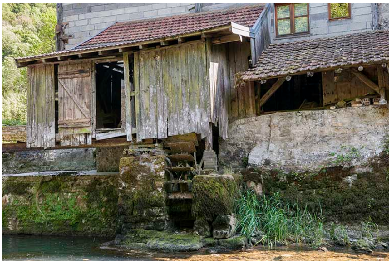
Façade nord. Le bâtiment d'eau.
