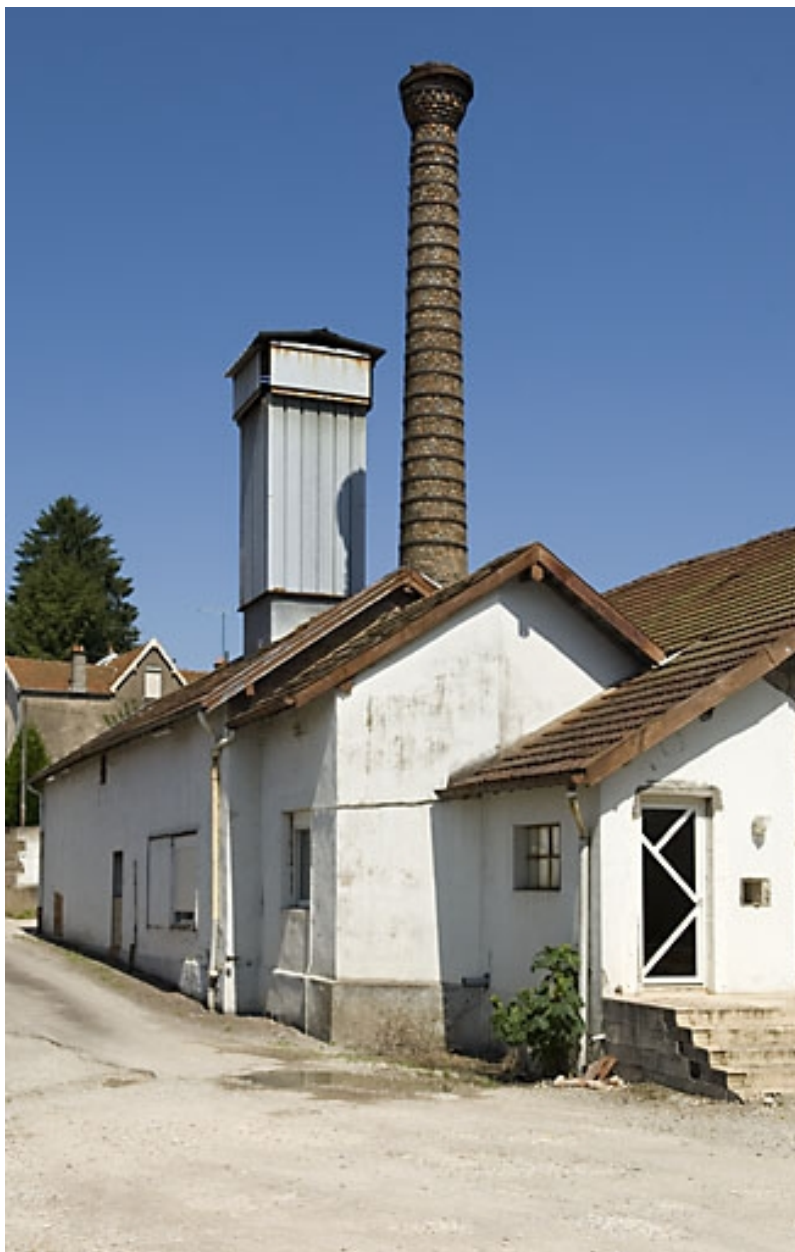
Atelier de fabrication et cheminées.
