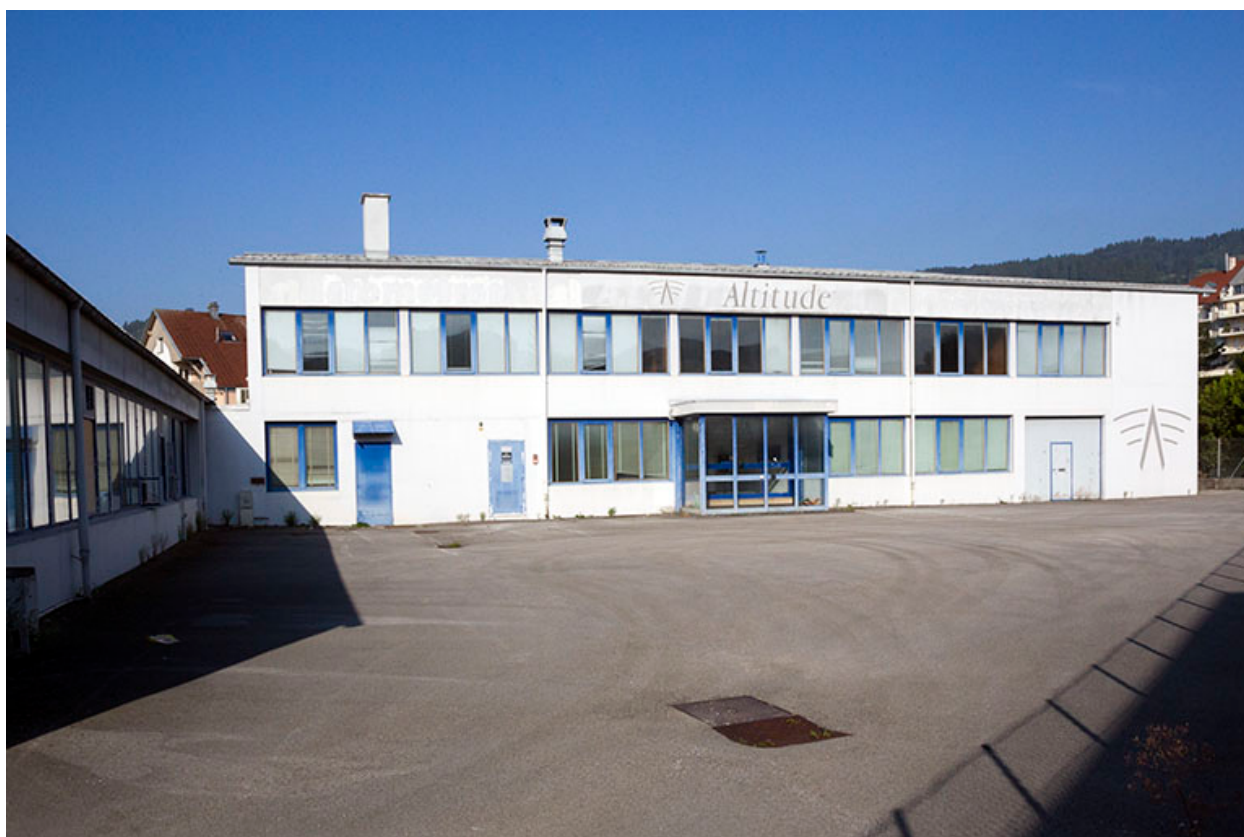
Bâtiment à étage : façade orientale.
