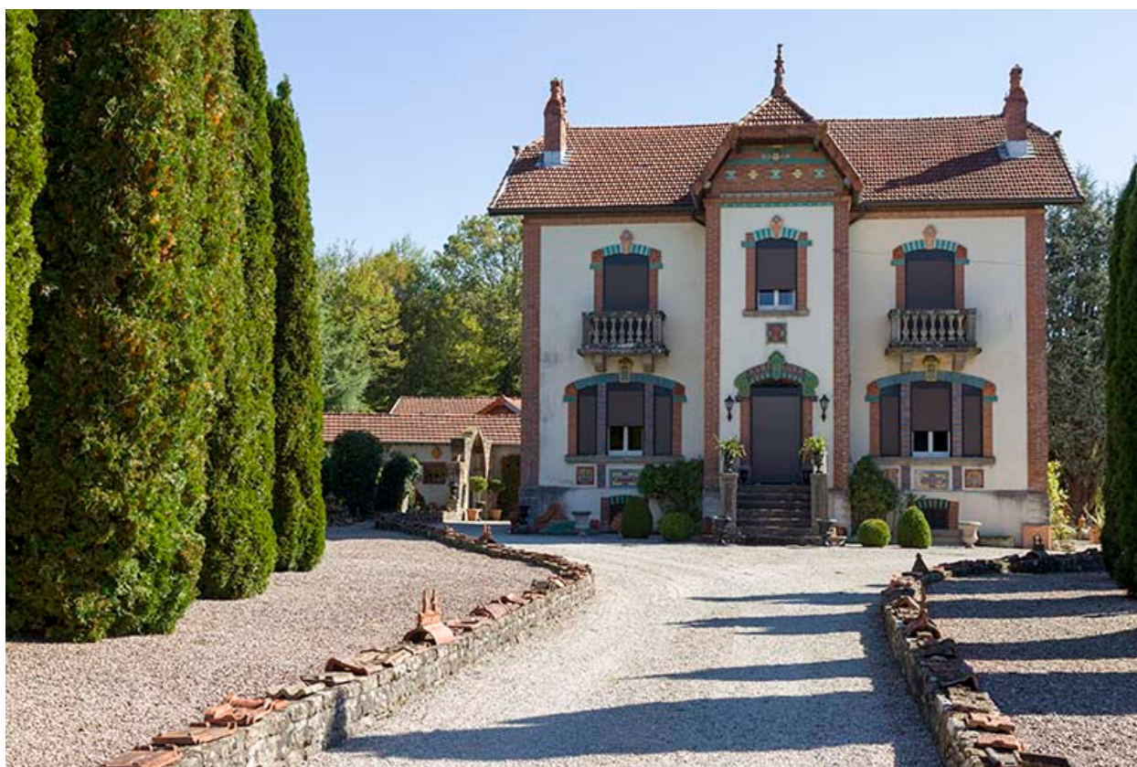
Ancien logement patronal.
