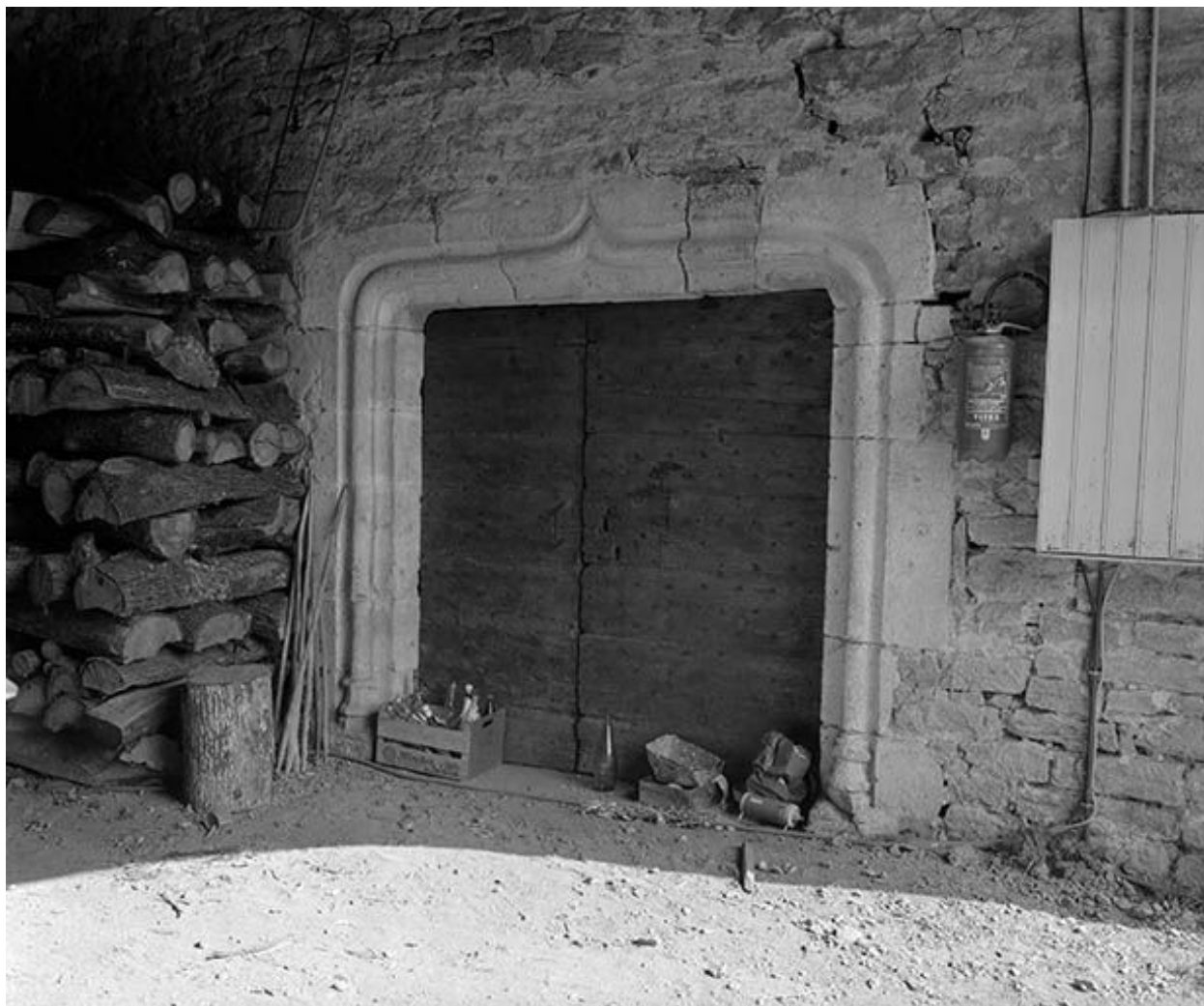
L'entrée du sous-sol sous le passage voûté.
