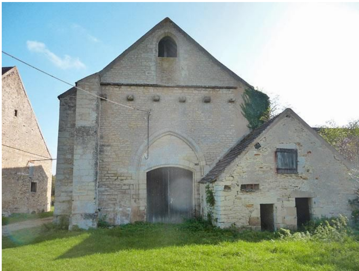
Façade de la chapelle et petite dépendance.
