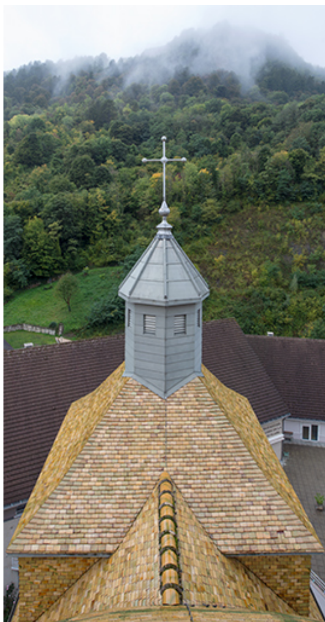
Toiture de la sacristie, depuis le lanterneau.
