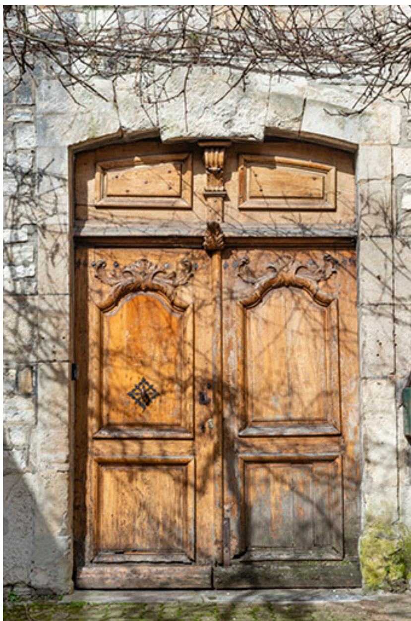
Porte droite sur cour (mur est).
