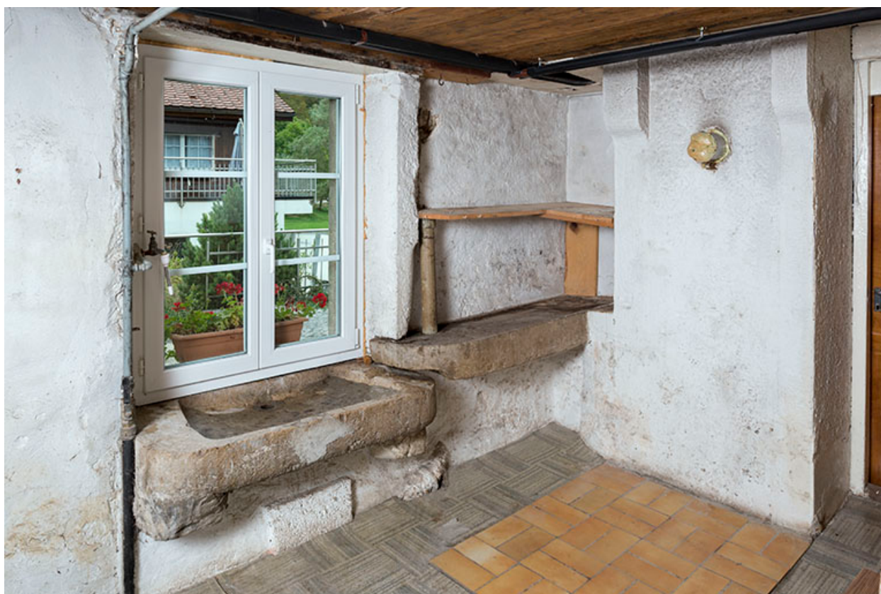
Premier étage de soubassement : ancien évier.
