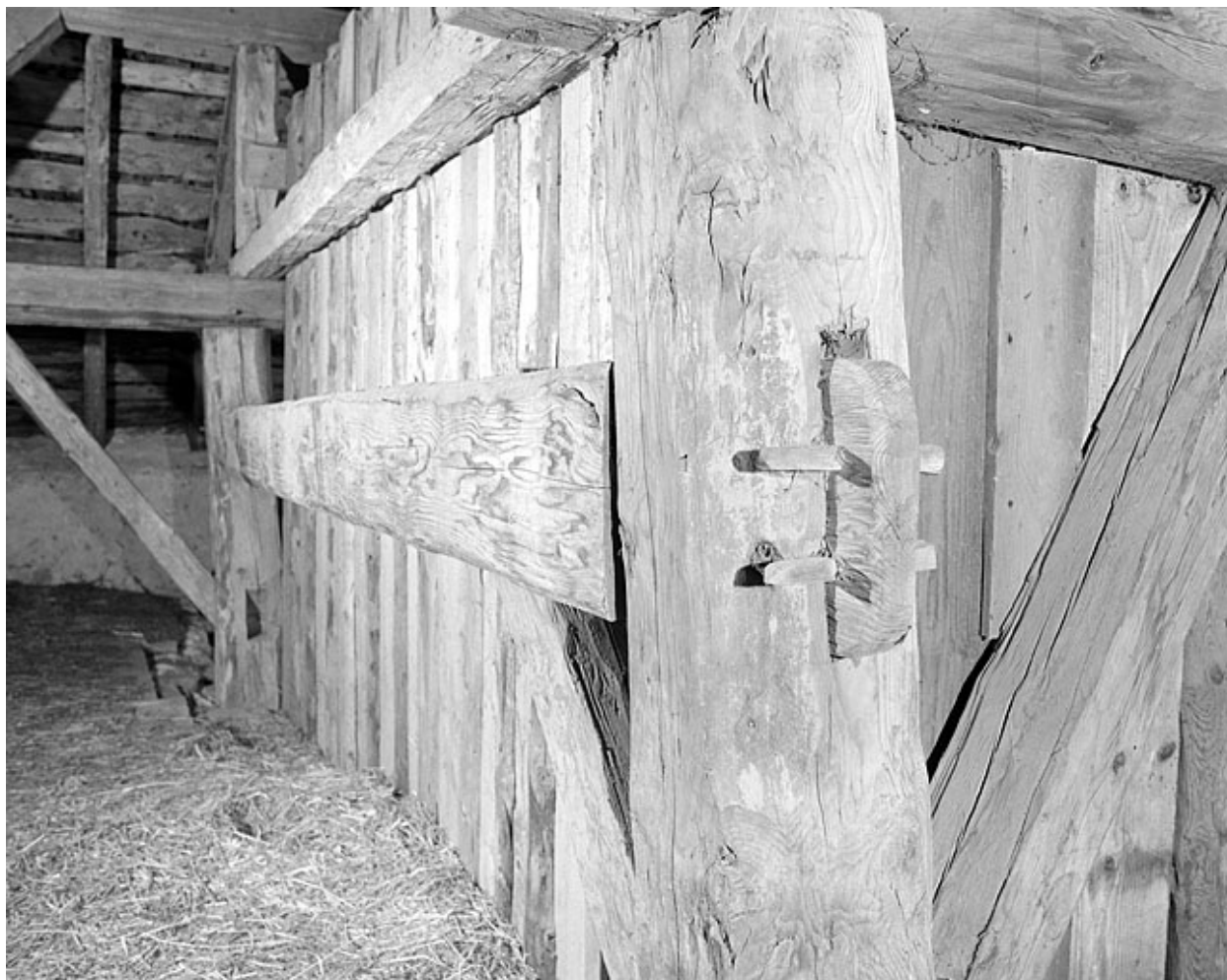
Assemblage de la charpente dans les combles.
