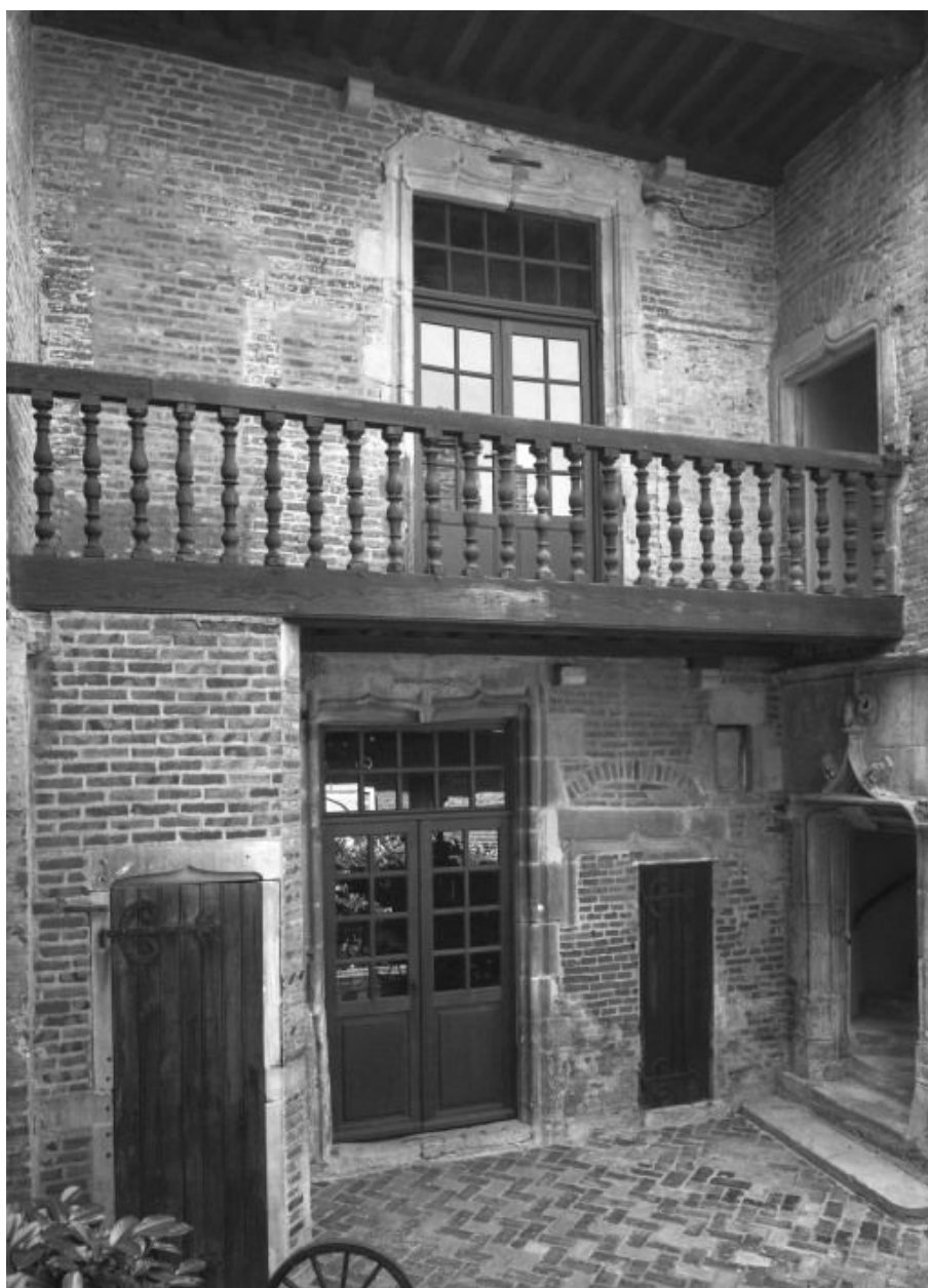
Corps principal, façade sur cour.
