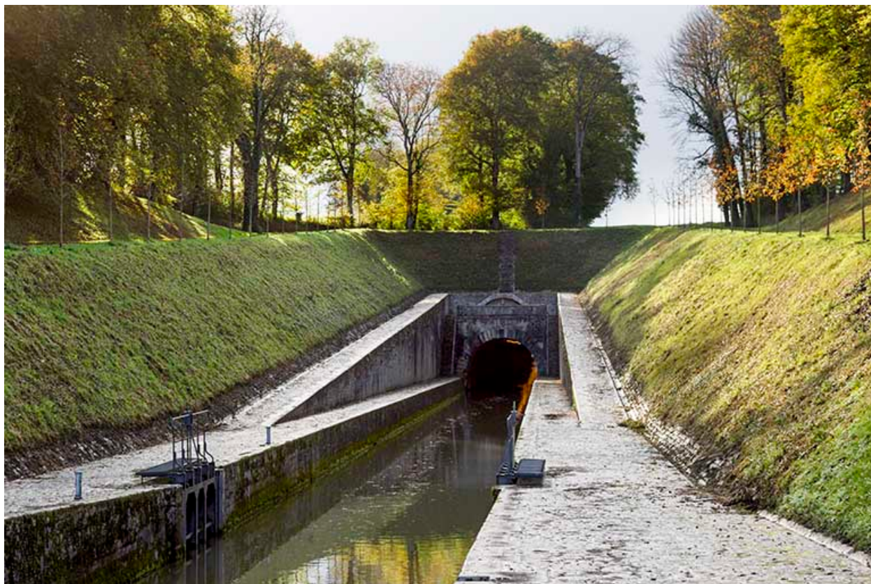
Le canal et le tunnel, vue amont.
