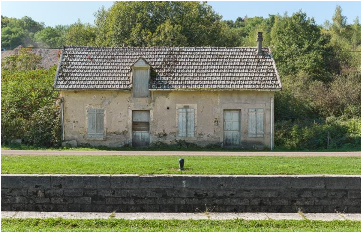
Vue de face de la maison éclusière.
