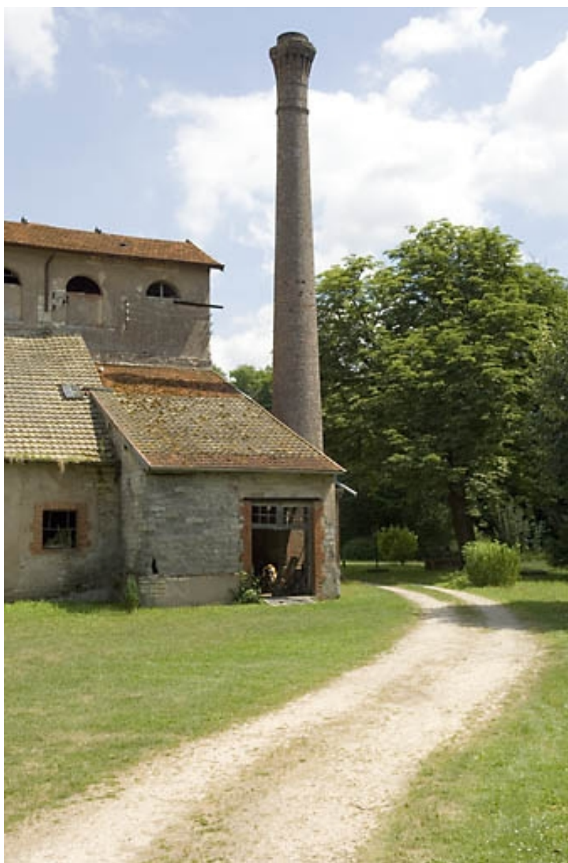
Chaudererie et cheminée au sud du haut fourneau.
