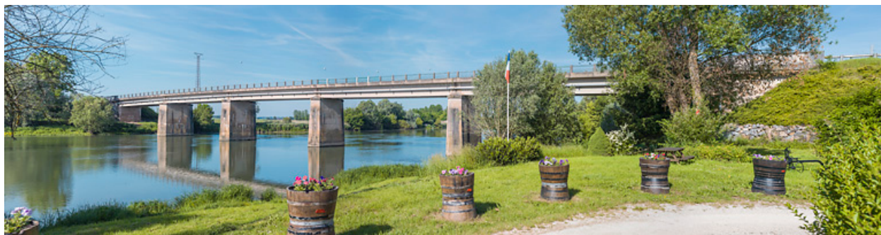
Vue d'ensemble du pont, de la rive droite.
