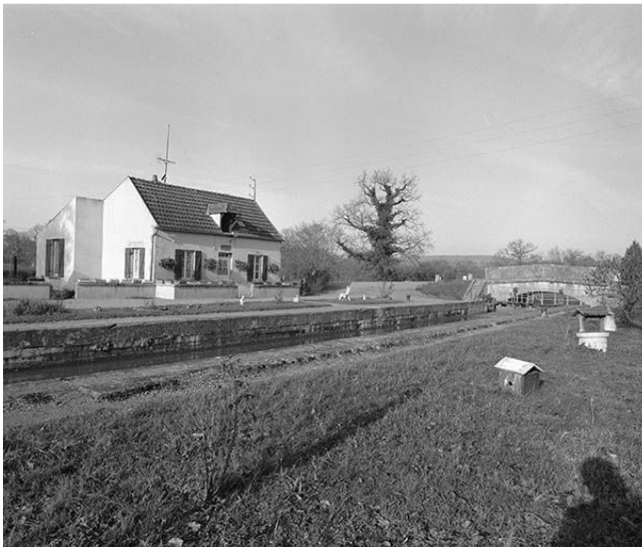
Vue d'ensemble prise de l'amont.
