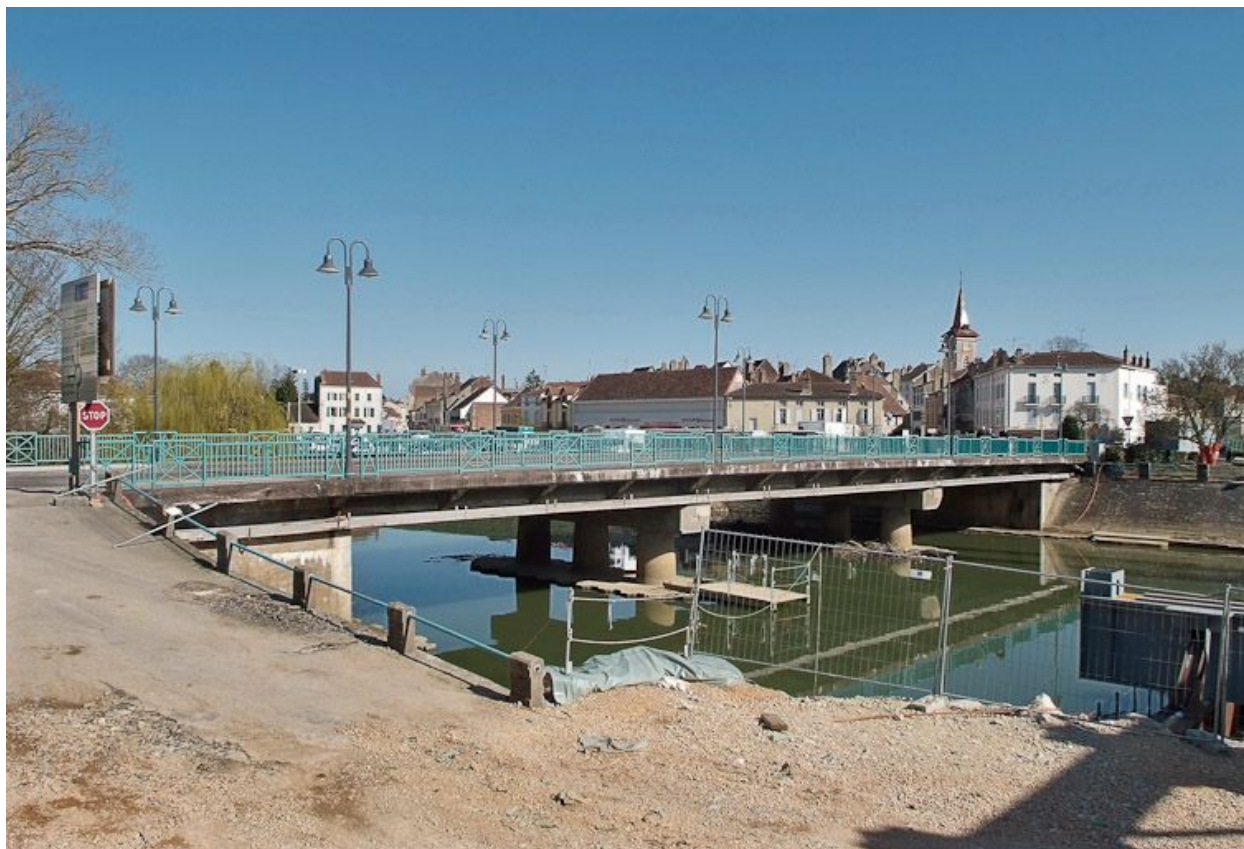
Pont routier sur la Seille, vue d'aval.
