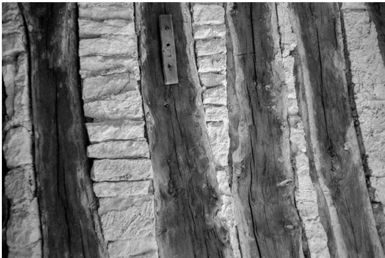
Intérieur des parties agricoles : le plafond.
