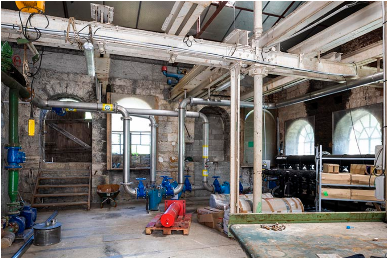
Bâtiment d'eau (actuellement station de pompage) : intérieur.
