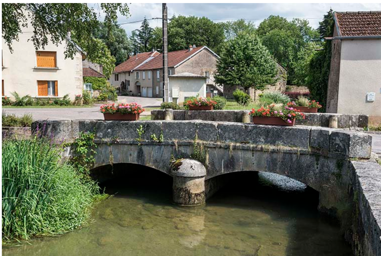
Face nord, vue depuis le nord.
