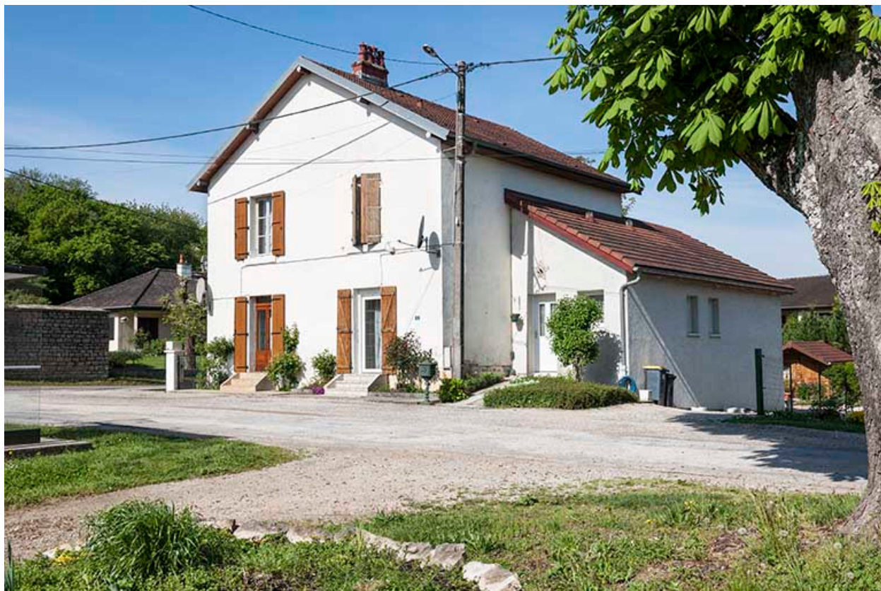
Logement ouvrier double (8-10 allée des Rompeux).
