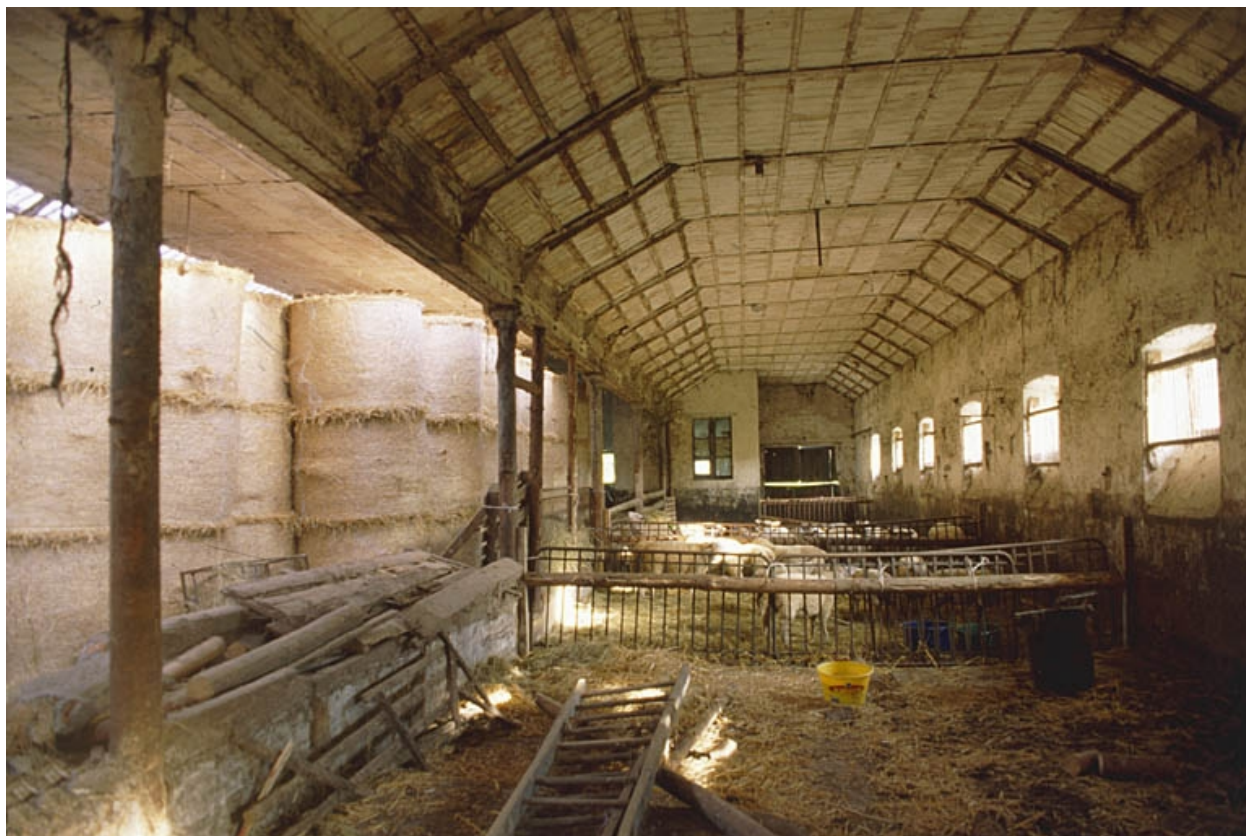
Travée sud de l'étable.
