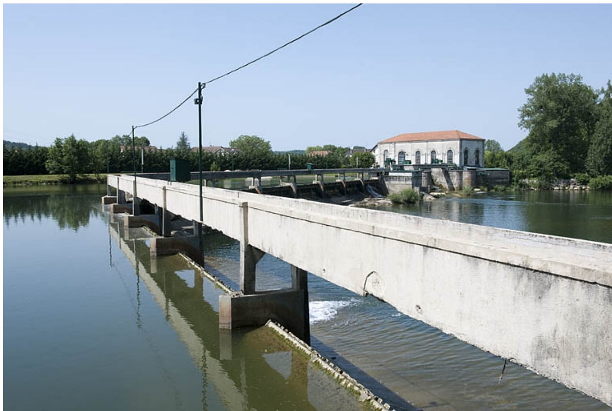
Vue éloignée depuis l'amont du barrage.
