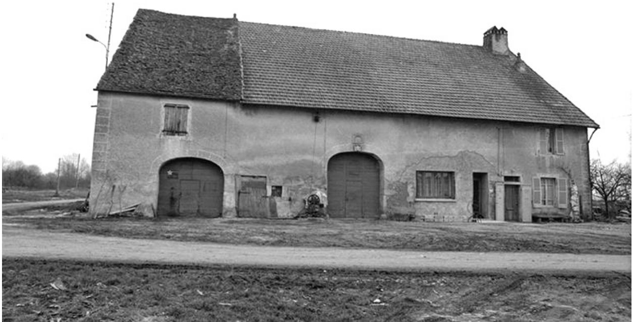
Ferme située le long du chemin vicinal ordinaire n° 4.
