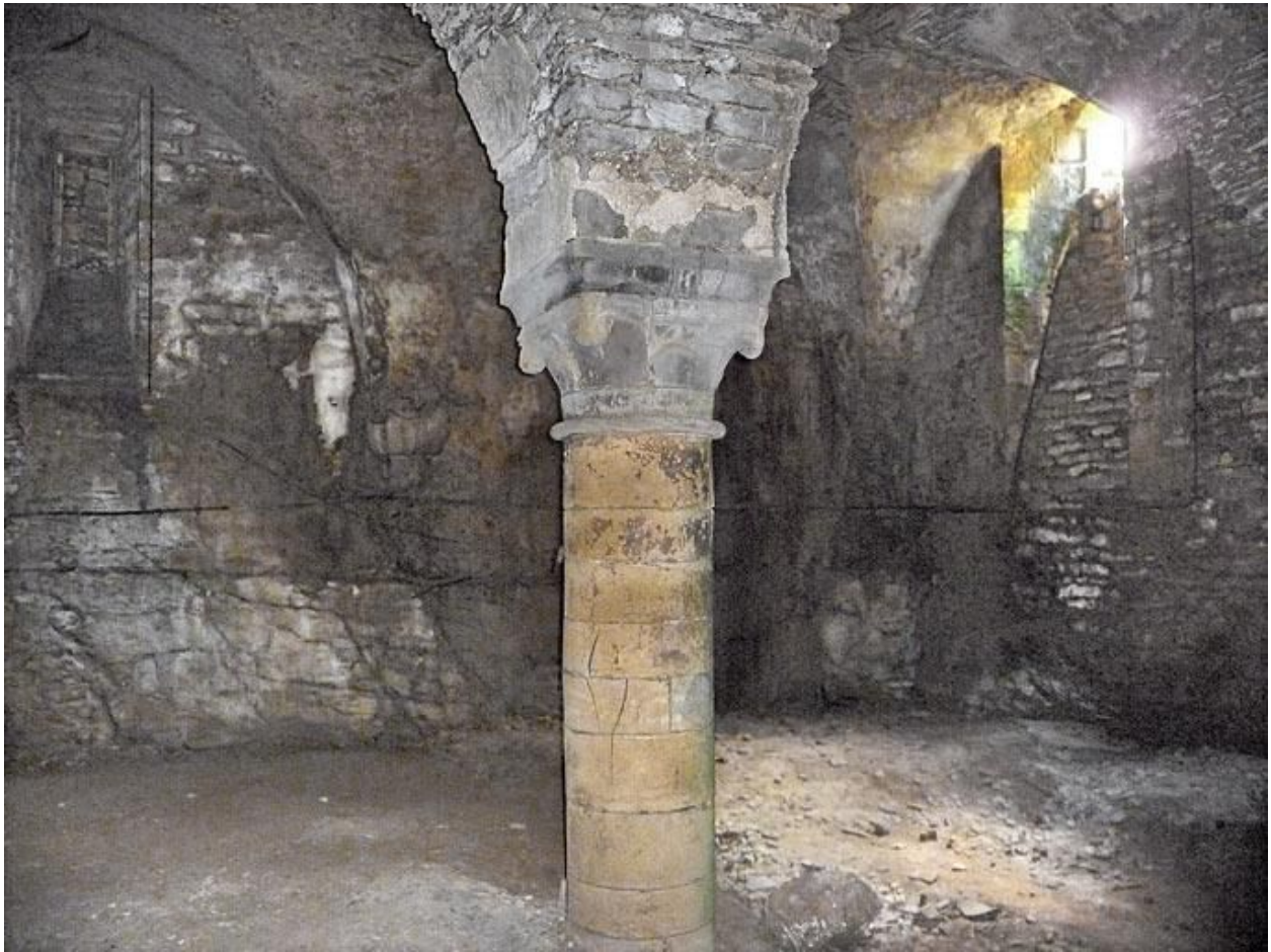
Cave sous la grange, vue d'un angle.
