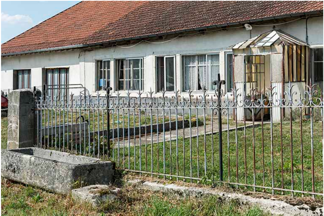
Fenêtres de l'atelier sur la façade antérieure.
