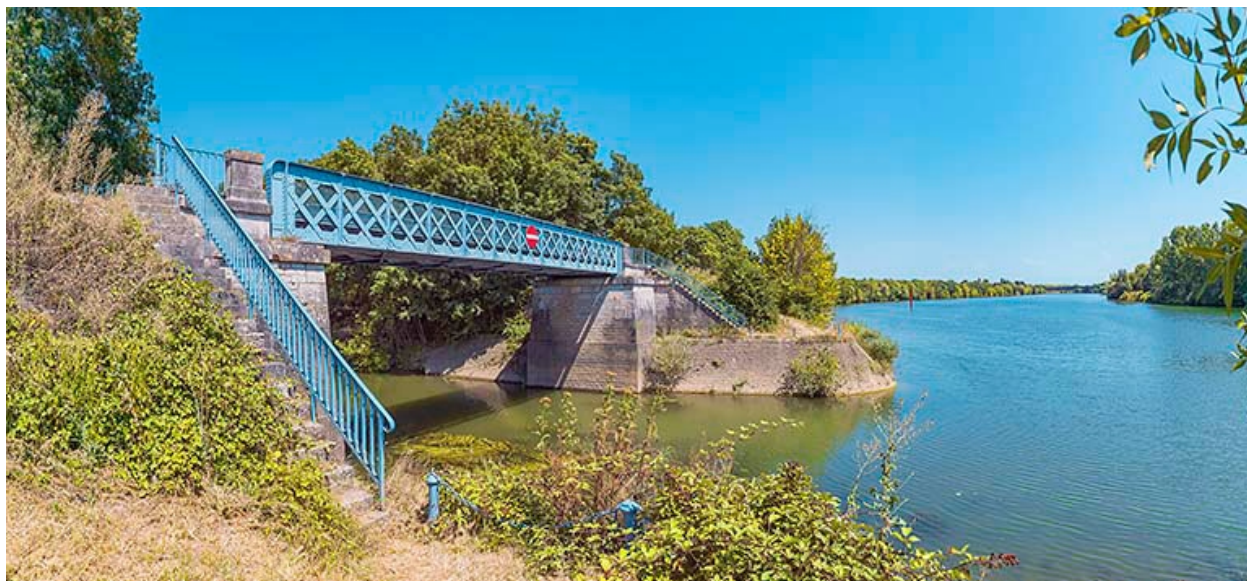
Vue d'ensemble du pont sur la Dheune.
