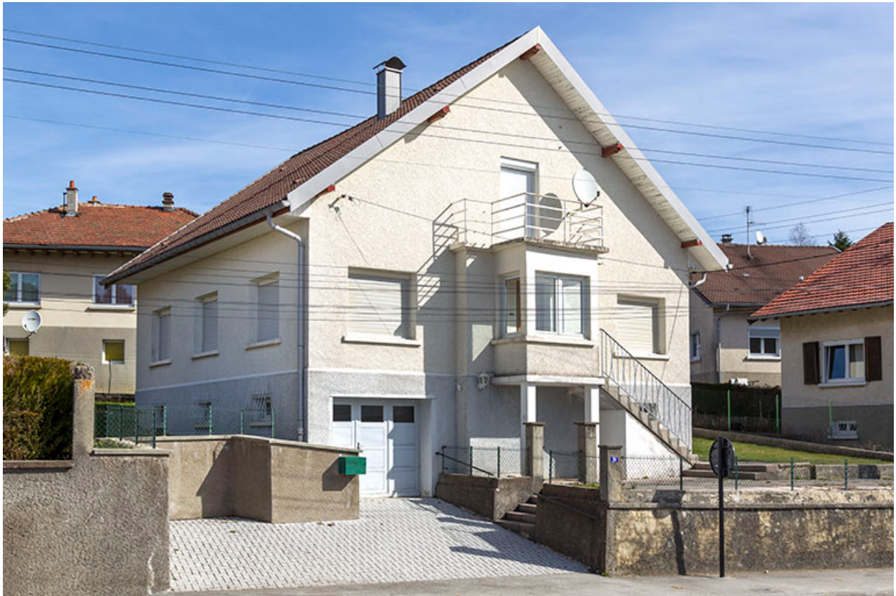
Façades antérieure et latérale gauche.
