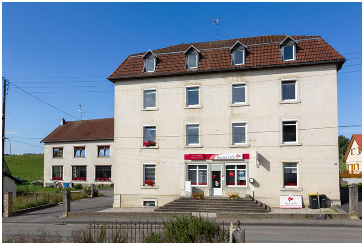
Logement patronal : façade antérieure.
