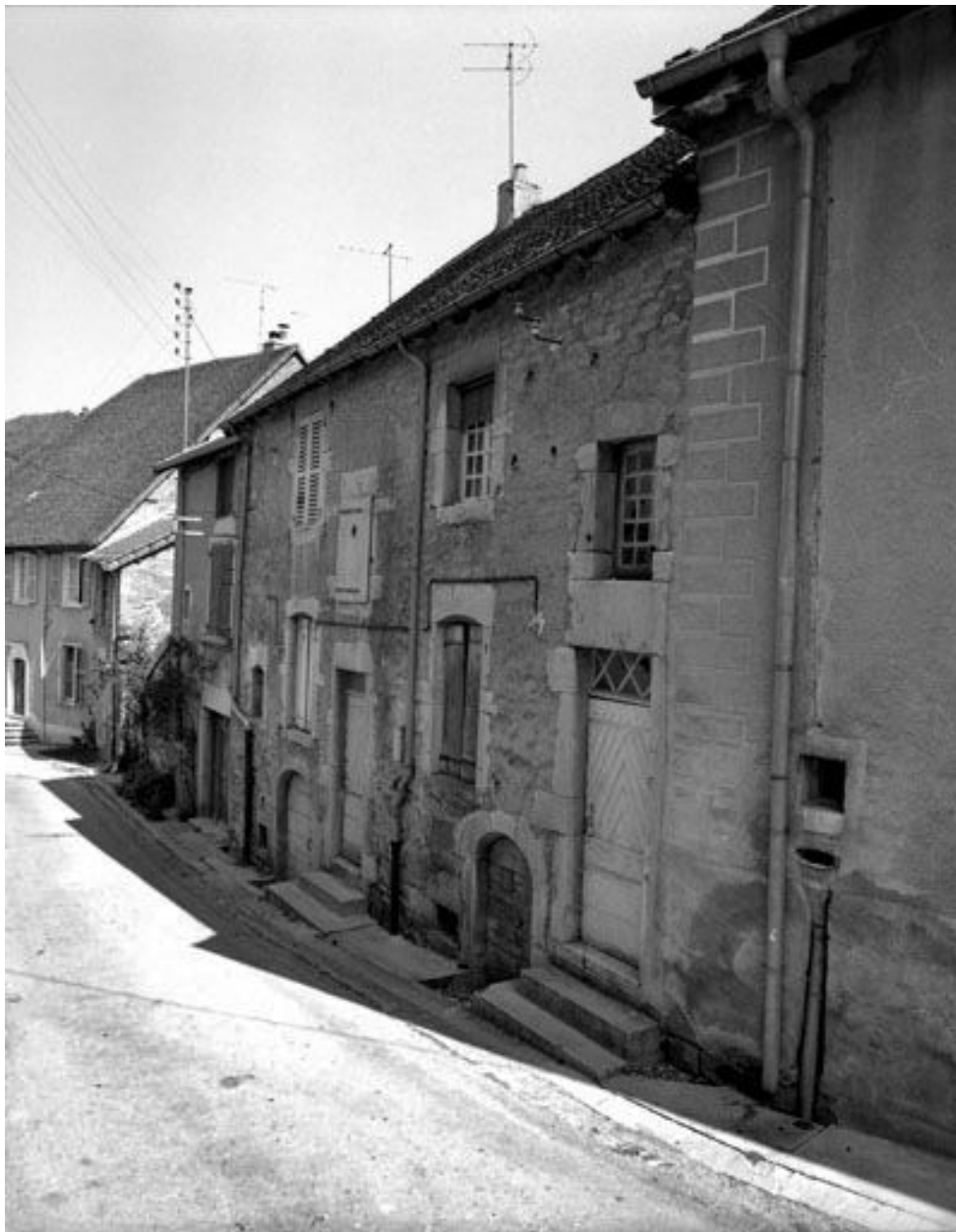
Maison de vigneron située rue des Vignerons.
