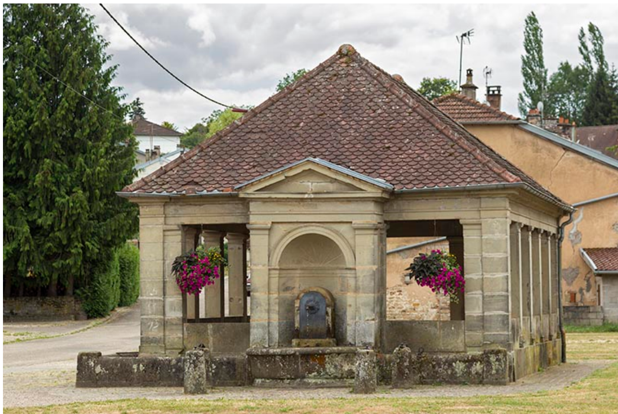
Fontaine-lavoir de la rue Charrière de Vouécourt.
