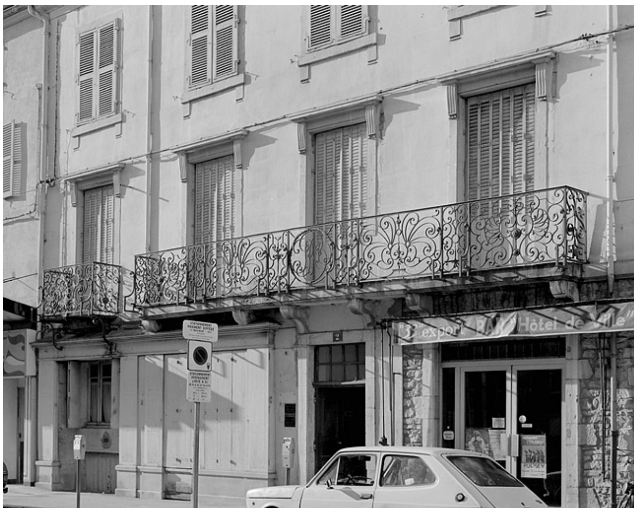
Façade antérieure, vue partielle.
