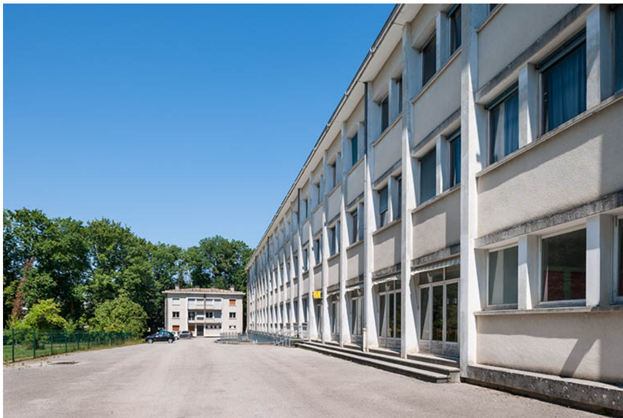
Façade de l'externat, en arrière-plan logements.
