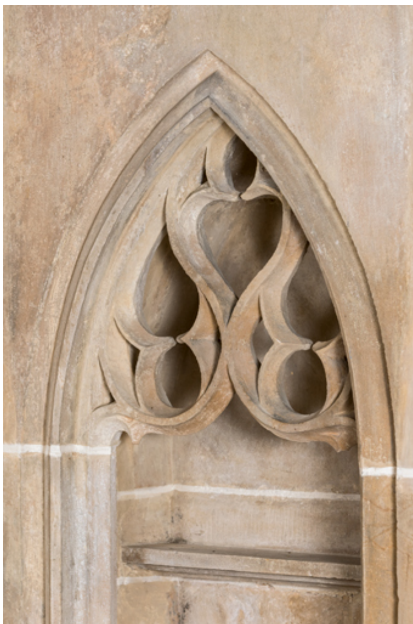
Détail : remplage de l'arc.
