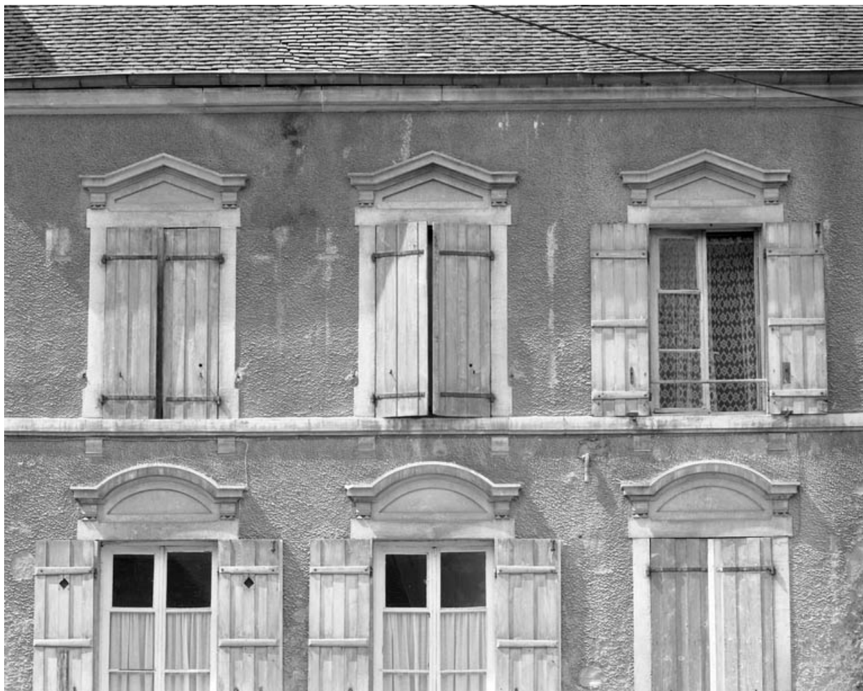
Façade sur rue : détail des baies.
