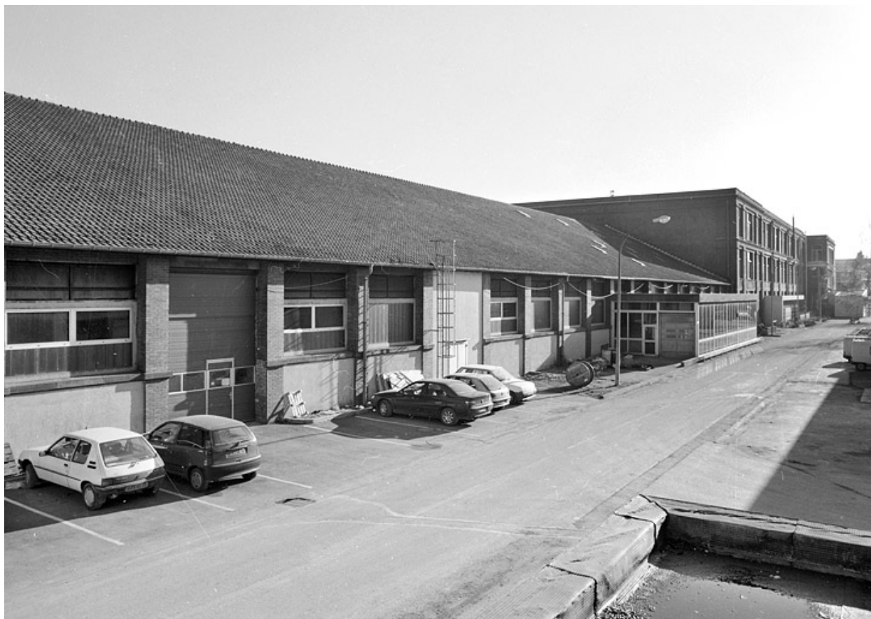
Atelier de retordage : façade ouest à mi-parcours.
