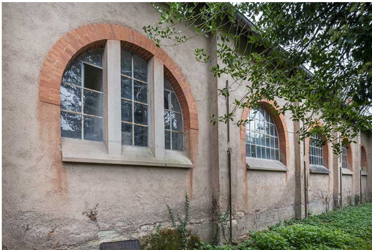
Mur-gouttereau ouest, fenêtre thermale.
