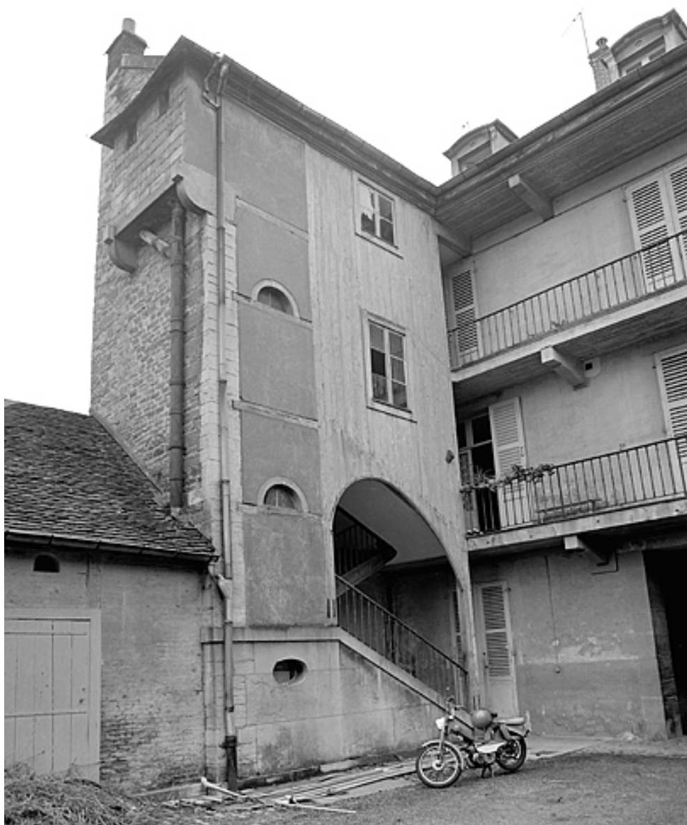
Escalier dans la cour.
