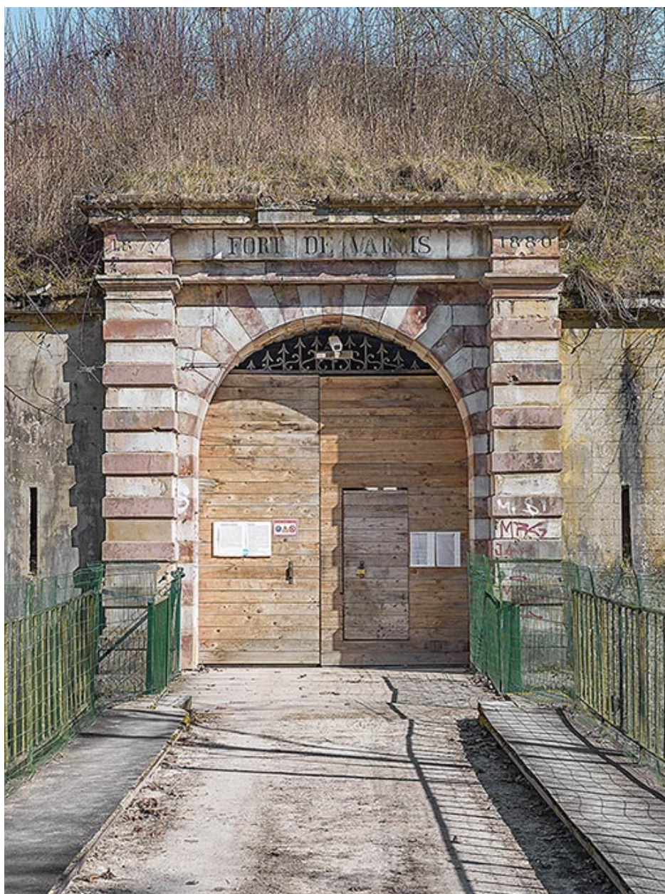
Porte d'entrée : détail.
